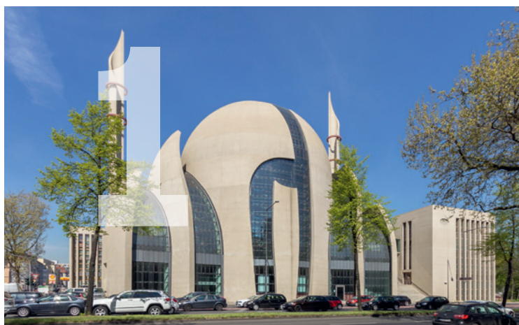
Ein wirkliches Leuchtturmprojekt: die Zentralmoschee in Köln. Die komplexe Tragwerkstruktur war eine Herausforderung, die IDK bravourös gemeistert hat
