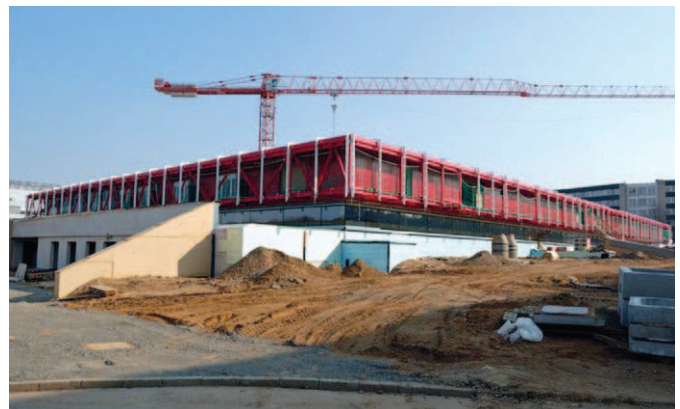
Bild 4. Nordwestansicht: Die Stahlfachwerkträger sind montiert und Rot lackiert. Das umgebende Gelände wird bis in Höhe des Glasbandes angeschüttet. (Fotos: 1,3 und 4 IDK Kleinjohann; 2 DLR)
