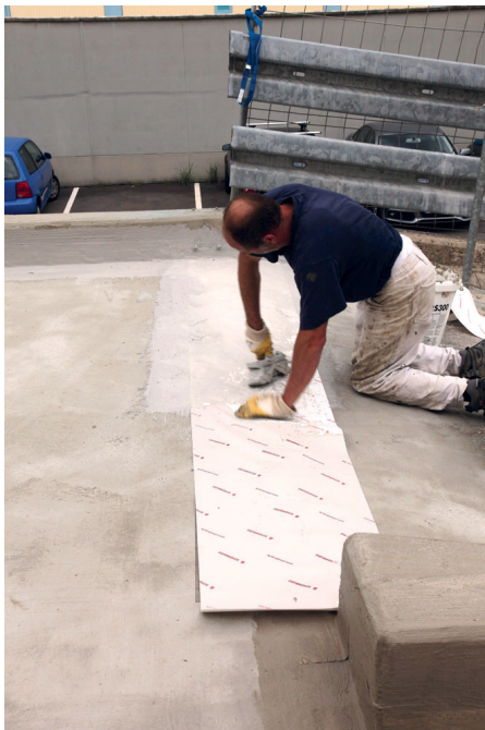
Bild 3. Verklebung der speziell angefertigten "Breitware" aus dem ASO®-Dichtband-2000-S mit AQUAFIN-RS300 (Fotos: Sachverständigenbüro Hagner)
