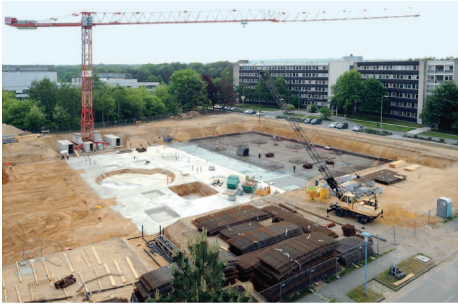
Bild 2. Das gesamte Gebäude wurde mit einer durchlaufenden, 0,60 m starken Betonplatte in WU-Bauweise als „weiße Wanne“ gegründet.
