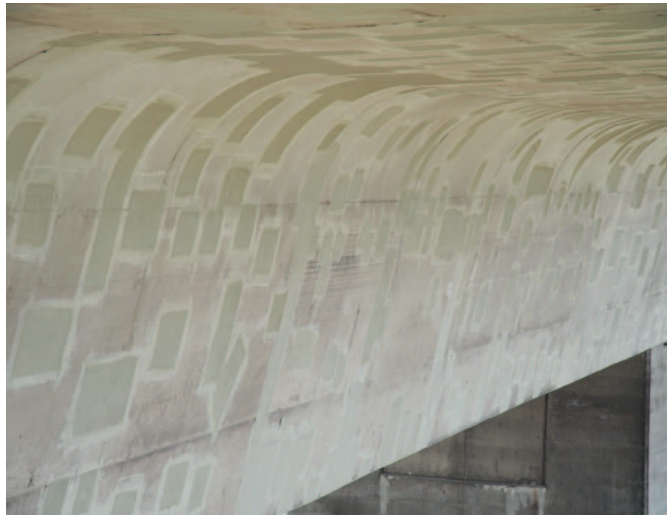
Bild 5 Brückenunterseite mit sanierten Korrosionsschäden.
